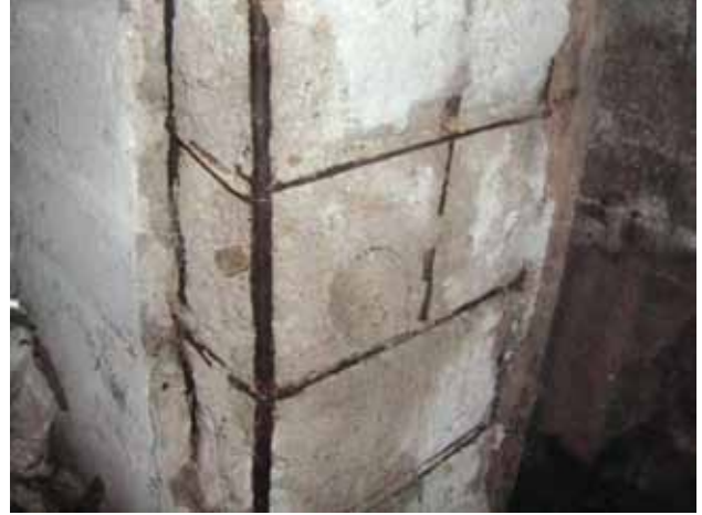
Fotoğraf 4. Betonarme taşıyıcı sistemde su sorunu.
