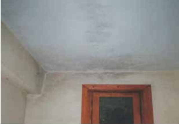
Fotoğraf 2. Banyoda oluşan su sorunu.
