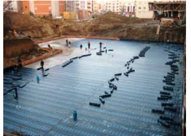
Fotoğraf 6. Yüzeysel su yalıtımı uygulaması.
