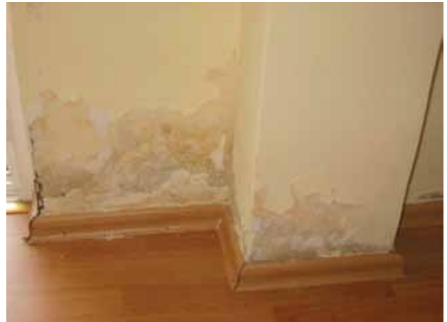
Fotoğraf 5. Yapı ürünlerinde oluşan bozulma.
