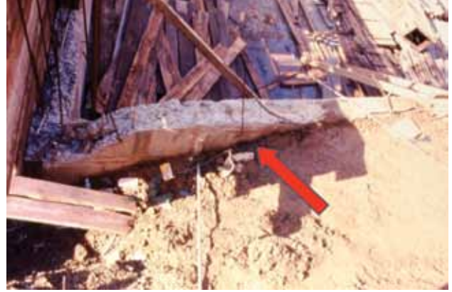
Fotoğraf 3. Su yalıtımı uygulanmayan bodrum kat.
