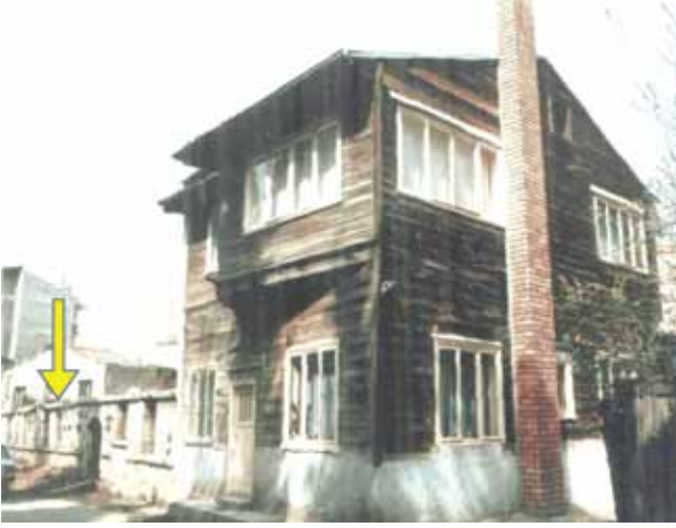
Foto 7. Aşçıbaşı Camisi zemin kat duvan ve komşu bina, 1992.
