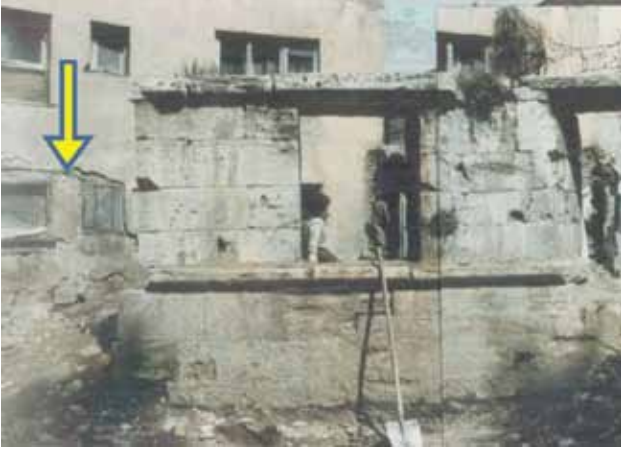
Foto 11. Aşçıbaşı Camii hazire duvarının yıkılmış kısmı, 1992.
