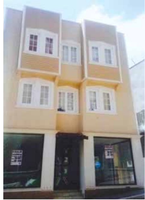
Foto 4. Sinop, II. grup yapı, yeniden yapım sonrası (SKTVKBK arşivi).
