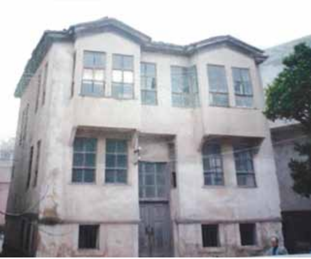
Foto 3. Sinop, II. grup yapı, yeniden yapım öncesi (Samsun KTVKBK arşivi).
