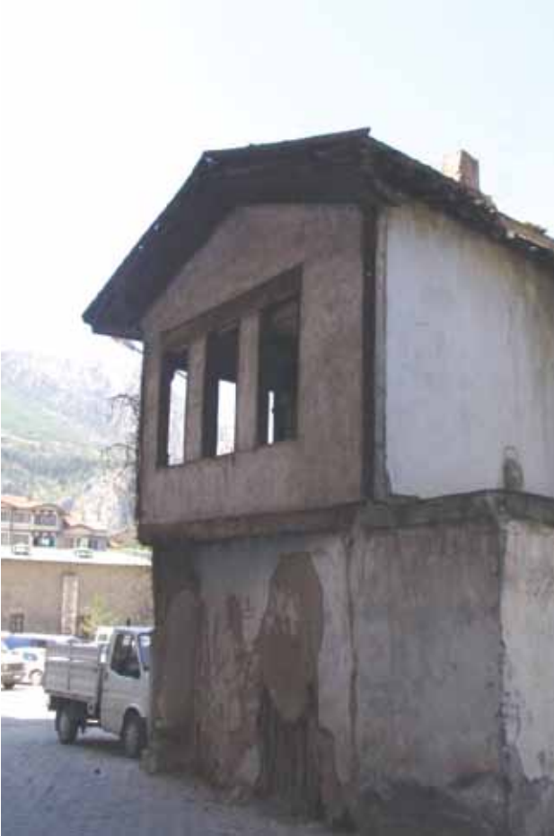
Doğu Cephesinden Görünüş
