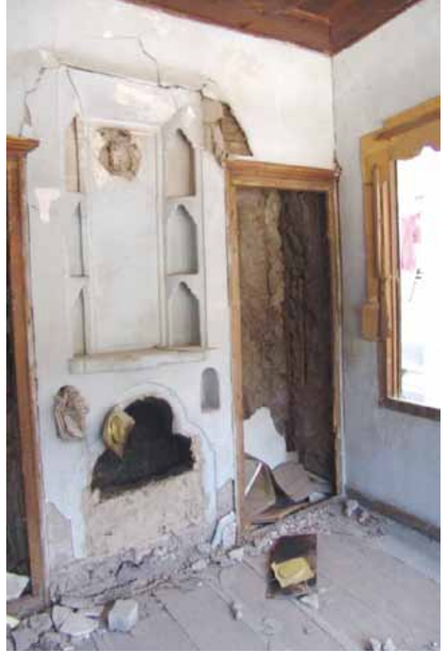
Şerbetlik ve Dolap Görünüşü
