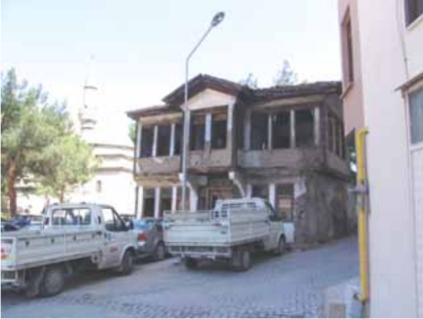
Güney Cephesinden Görünüş
