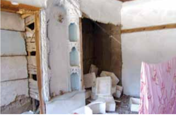
Şerbetlik ve Dolap Görünüşü
