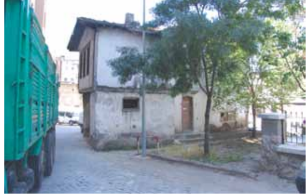
Kuzey Cephesinden Görünüş
