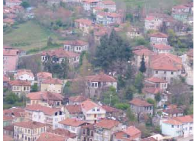
Alaçam kentsel dokusu Çeşme Mahallesi'ne bakış
