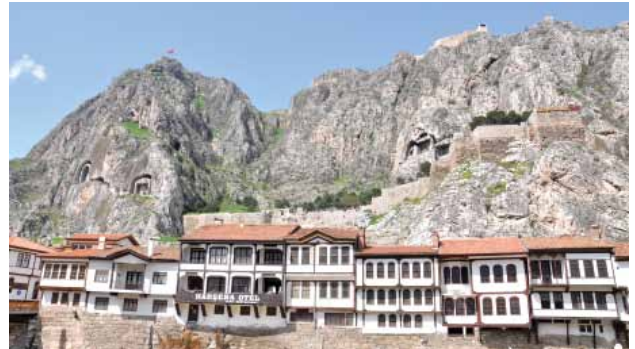
Nehir cephesinde cephe düzeni
