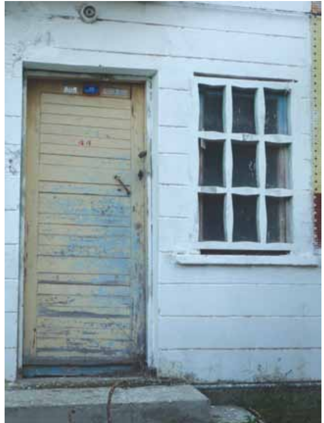
Resim 15. Giriş kapısı ve pencere üzerindeki özgün korkuluk.
