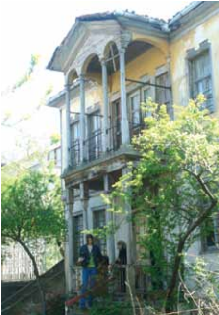
Açık çıkma (Balkonlu) örneği.
