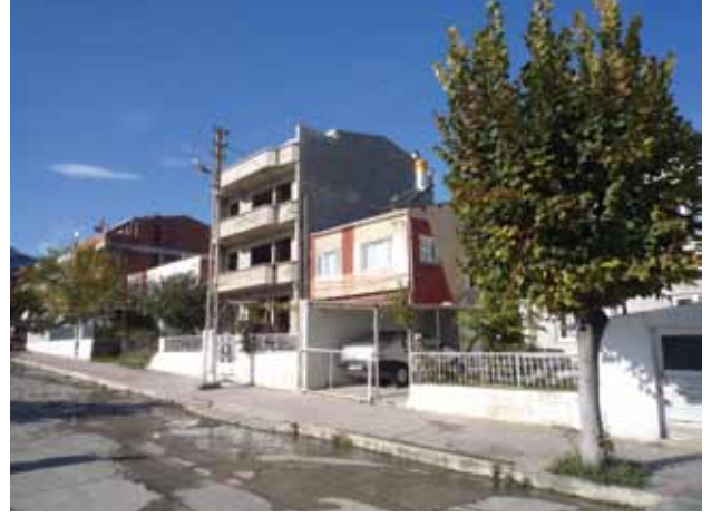
Resim 18. Tamamen yıkılan yangın evi yerine yapılan betonarme bina.
