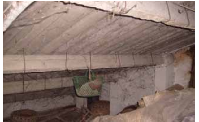
Resim 11. Çatı katı, prefabrik kirişlere asılan eternit örtü. &gt;&gt;
