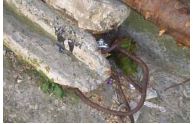
Resim 10. Sökülmüş prefabrik kirişler.
