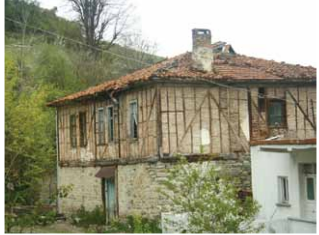
Düz cephe örneği.
