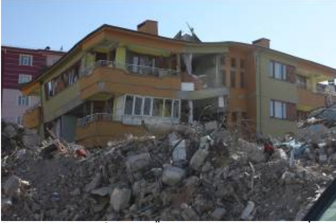
Erciş – Van Yolu Caddesi Üzerinde Yıkılan Konut ve İşyeri Binası
