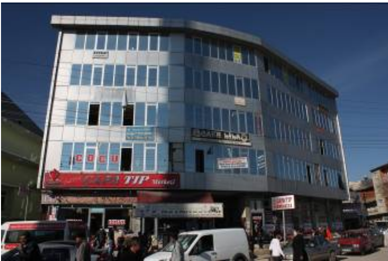
Erciş'te Ağır Hasarlı Olan Tıp Merkezi
