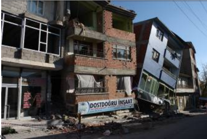
b Erciş – Van Yolu Caddesi Arka Sokaklarında Devrilen Konut ve İşyeri Binaları
