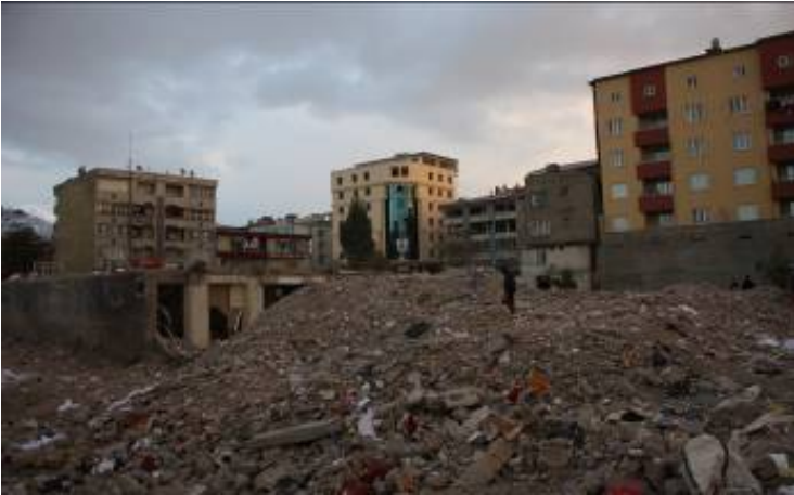
Van Merkezinde Yıkılan İş Merkezi
