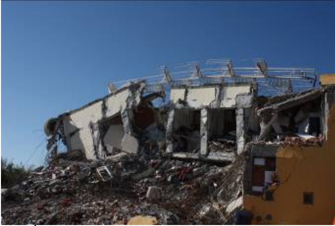
Erciş İlçesinde Yıkılan Bir Otel Binası
